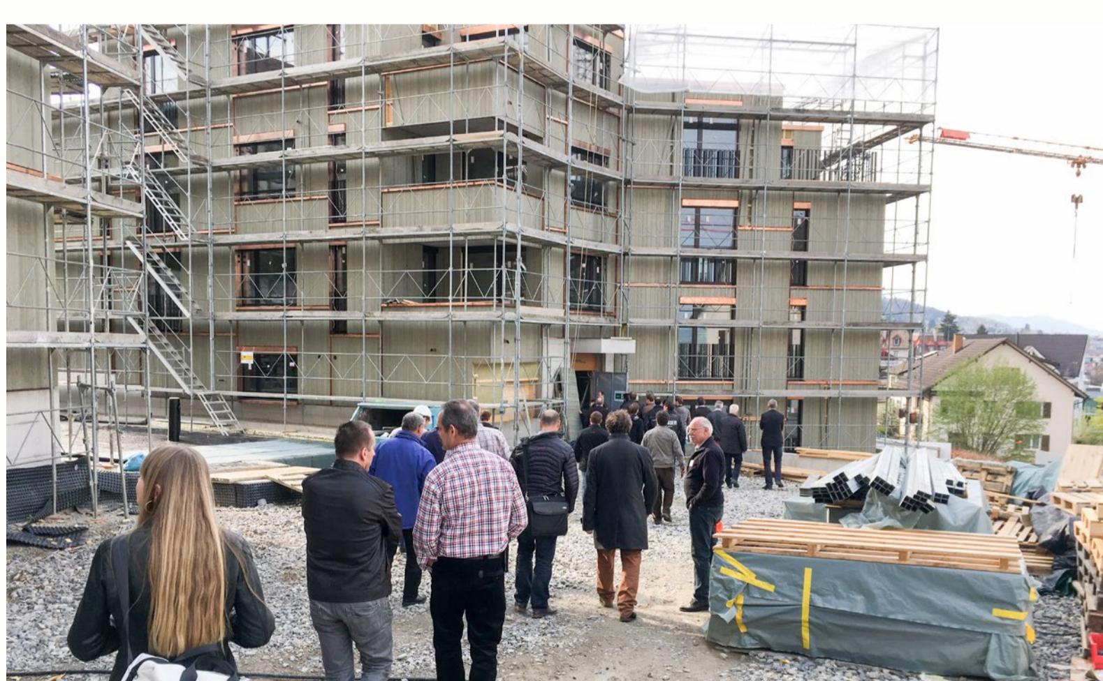
Zwischen den Referaten und dem Apéro war eine Besichtigung der Baustelle möglich.
