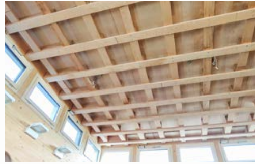
Bi-axiale Laubholzdecke mit zahlreichen Messpunkten.
