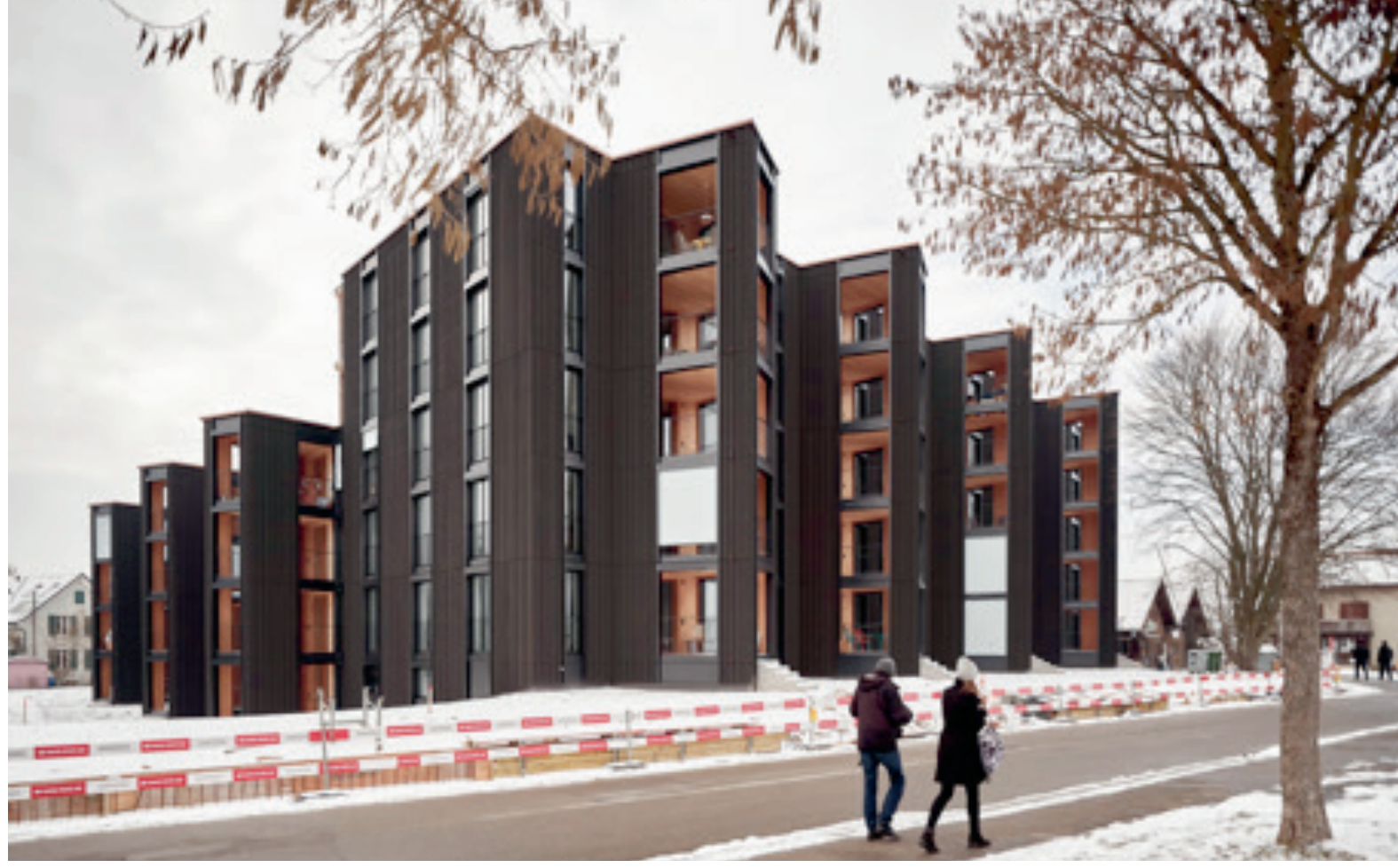
Die neue Überbauung wurde als Holz-Beton-Verbund konstruiert und liegt nur wenige Gehminuten vom Bahnhof Winterthur Seen entfernt.
