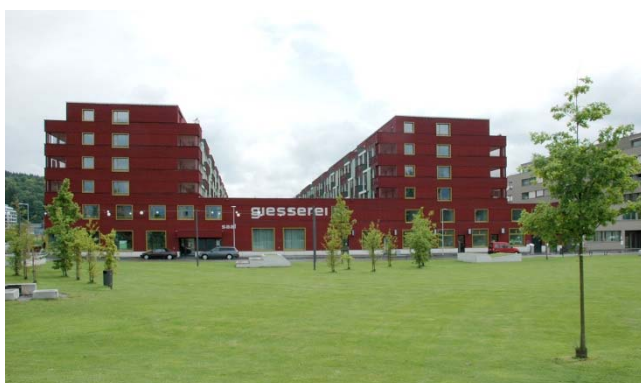
Das grösste Wohnholzhaus in Europa mit über 160 Wohnungen, Restaurant, eine öffentliche Bibliothek, Velowerkstatt etc.
