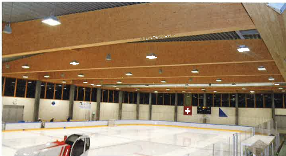
Alleine in den Tragwerken der Dachkonstruktion stecken fast 600 m 3 Holz.
